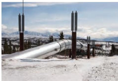
(الف) شکل ۱۴- حفاظت از آهن با منیزیم، (الف) بدنه کشتی (ب) لوله‌های نفتی (ب)
