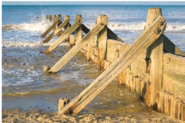
نصب حفاظ عمودی
