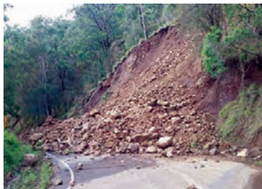
زیربُری دامنه برای ساخت جاده و وقوع لغزش
