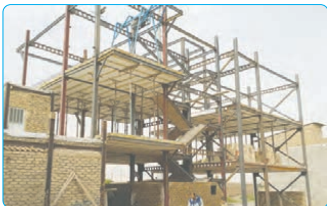
خانه‌ی در حال ساخت
