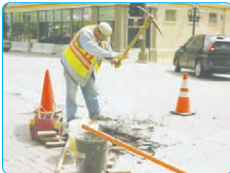
استفاده از کلنگ در کندن زمین
