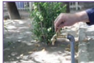
خ - آزمایش آب بندی شیر
