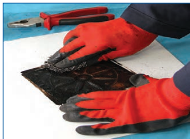
شکل ۱۱-۱۱- ساب زدن سطح پلاک مسی
