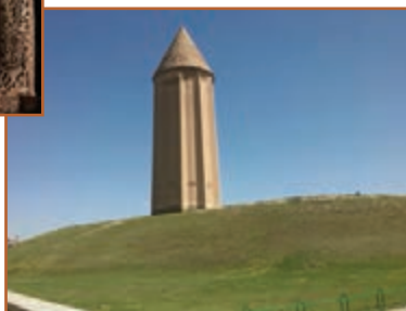
شکل ۲۷-۸- بنای گنبد قابوس، بلندترین برج آجری دنیا
