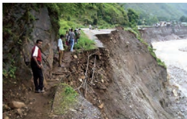
لغزش در اثر زیربُری رودخانه در هند
