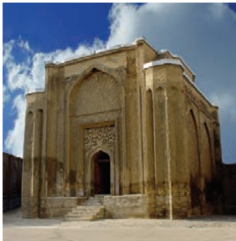
گنبد علویان از بناهای دوره سلجوقی - همدان
